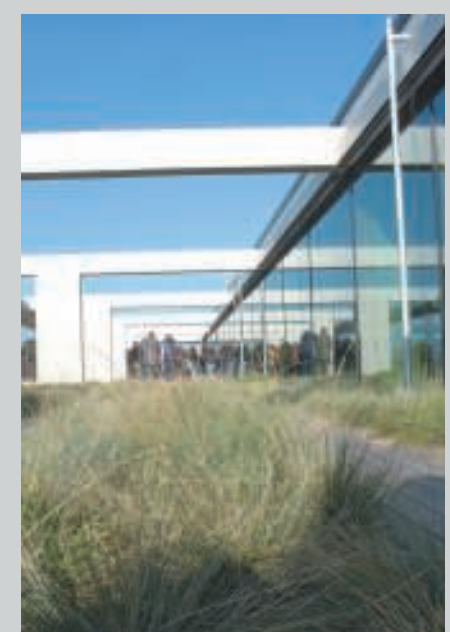
neubau - landesamt für finanzen architekten: wulf architekten
