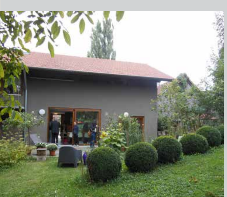
neubau eines wohnhauses bei ergoldsbach
