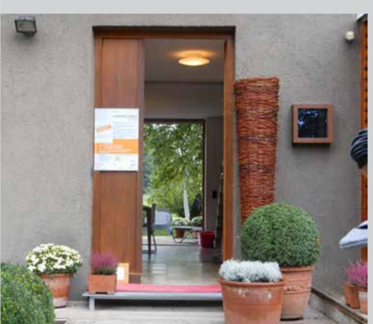
neubau eines wohnhauses bei ergoldsbach
